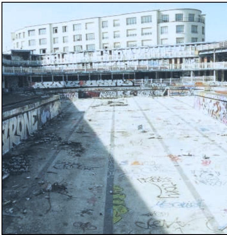
PARIS XVI e . Les premiers travaux de réhabilitation de la piscine Molitor, fermée et abandonnée depuis 1989, devraient démarrer dans un an. (LP/PHILIPPE DE POULPIQUET.)
